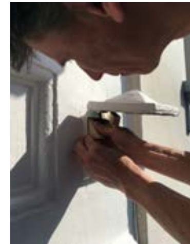
Inrichting aan de Dethystraat te Sint-Gillis. Opmeten van de steigergaten / aanbrengen van het isolatiemateriaal (houtvezel) / lijmen van de houtelementen / drogen
