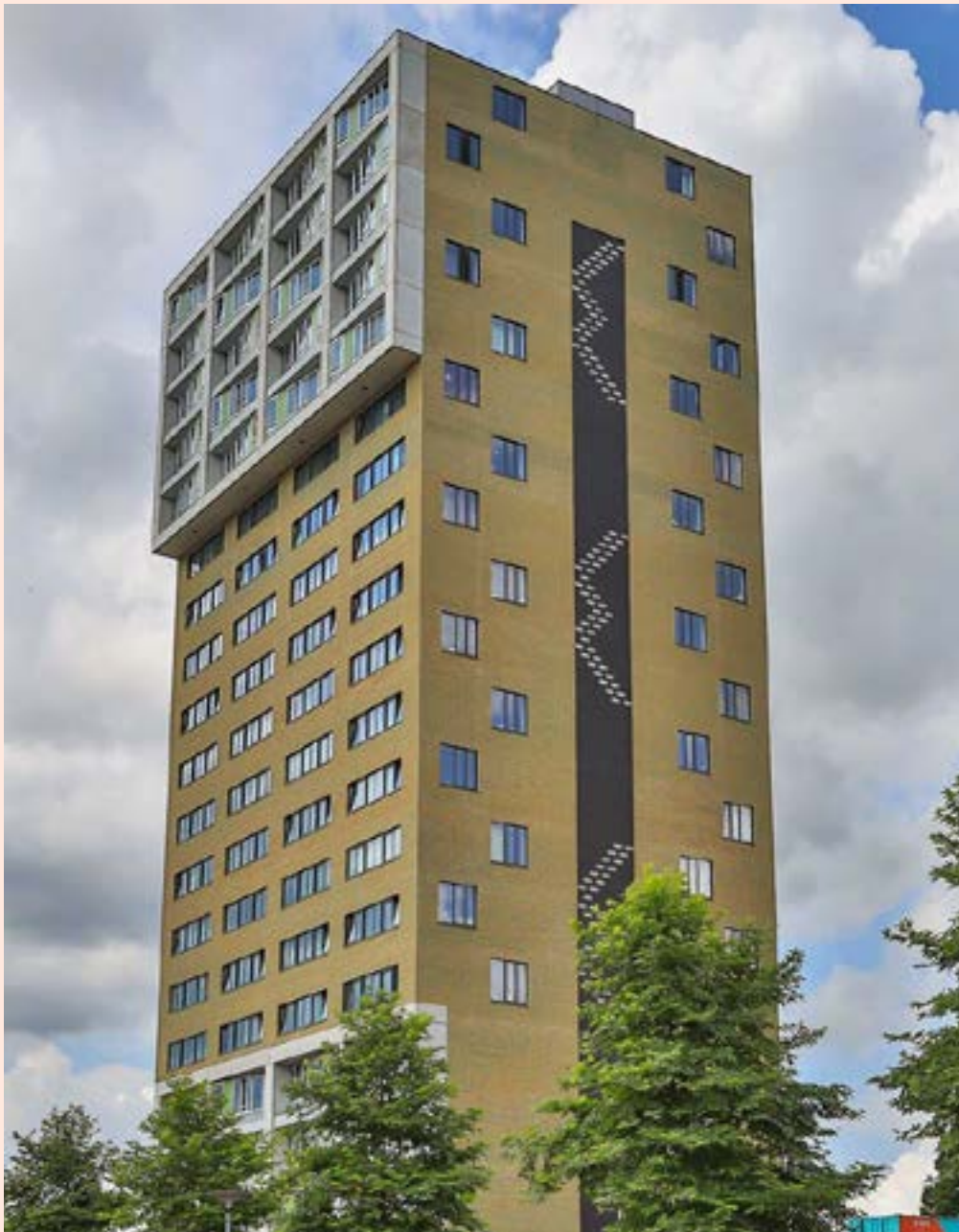
Gebruik van gierzwaluwkasten als sierelement op de "De Groenling" woontoren in Groningen. © Bureau Noordeloos architecten Groningen
