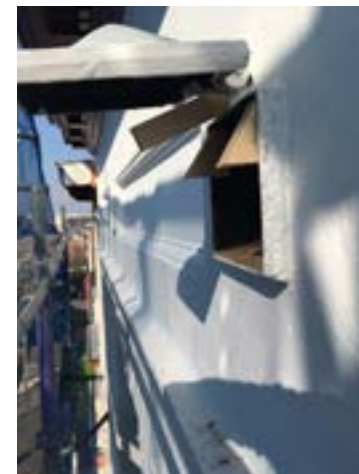
Inrichting aan de Dethystraat te Sint-Gillis. Opmeten van de steigergaten / aanbrengen van het isolatiemateriaal (houtvezel) / lijmen van de houtelementen / drogen
